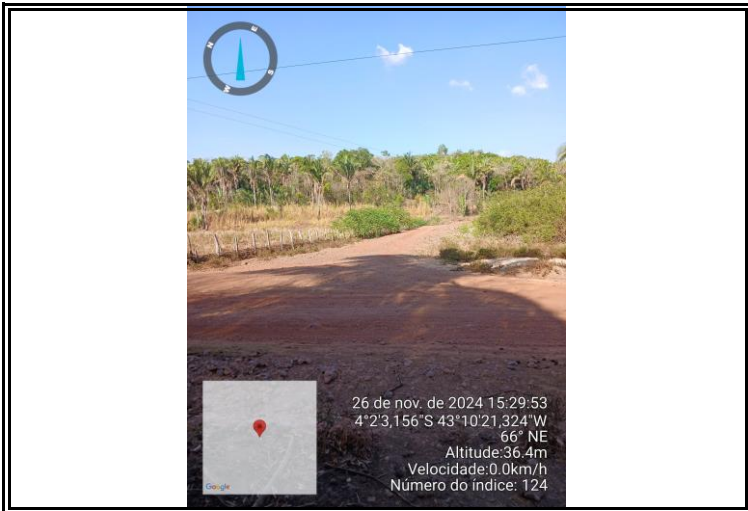
FOTO 13 - INICIANDO NA ESTRADA VICINAL COM FINAL NO POVOADO PEDRINAHS
