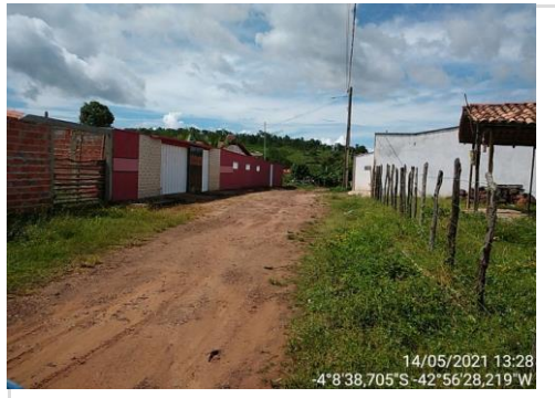
RUA 04 - FINAL (Comentários, coordenadas, etc.)
